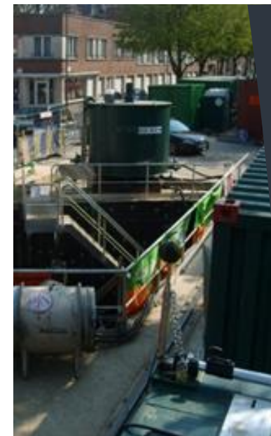
Surveillance acoustique et vibratoire du chantier de construction du tunnel ferroviaire Watermael-Josaphat, Bruxelles.
